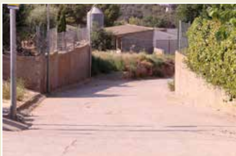
MEJORA RED ABASTECIMIENTO CALLE BARBASTRO
