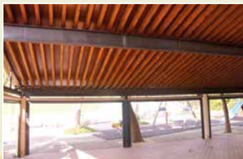
REFORMA PORCHE PARQUE MUNICIPAL
