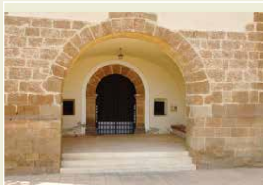
RAMPA DE ACCESO A LA ERMITA DE SAN JOAQUÍN
