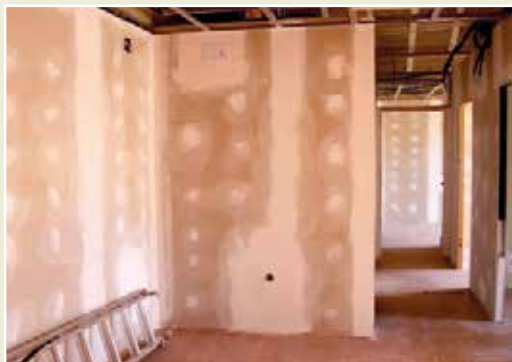
VIVIENDA EN CONSTRUCCIÓN EN LA CALLE MAYOR
